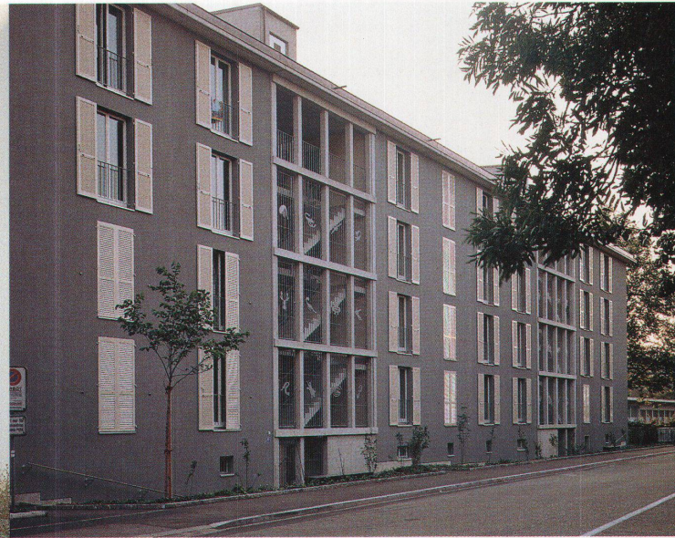
Strassenfassade mit französischen Fenstern und offenen Treppenhäusern, die den Lichtschlitzen des gegenüberliegenden Busdepots nachempfunden sind
