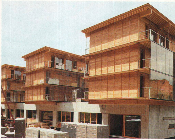
Die Querriegel des Internats. Die Gläser vor den Laubengängen dienen als Wetterschutz
