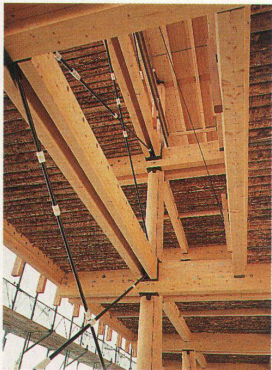
Die Tragkonstruktion während des Baus. Blick nach oben durch die Deckenaussparungen für die geraden Treppen. Baumstammstütze, Primär- und Sekundärträger sind klar sichtbar. Die Rundhölzer der Deckenelemente ebenfalls
