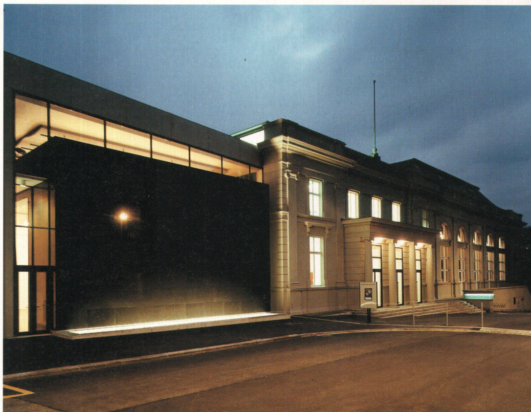
Die Fassade gegen den Schlossplatz hin: links die Erweiterung, rechts der Altbau
