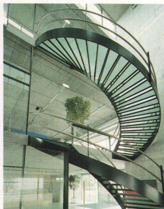
Blick aus dem Erdgeschoss ins Treppenhaus: Perfektion ist Weglassen
