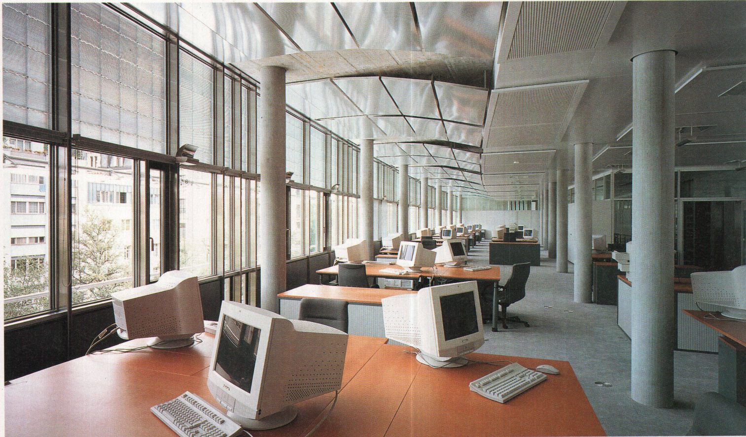
Büro im 2. Obergeschoss. Die Prismen im oberen Teil der Fenster sind deutlich sichtbar
