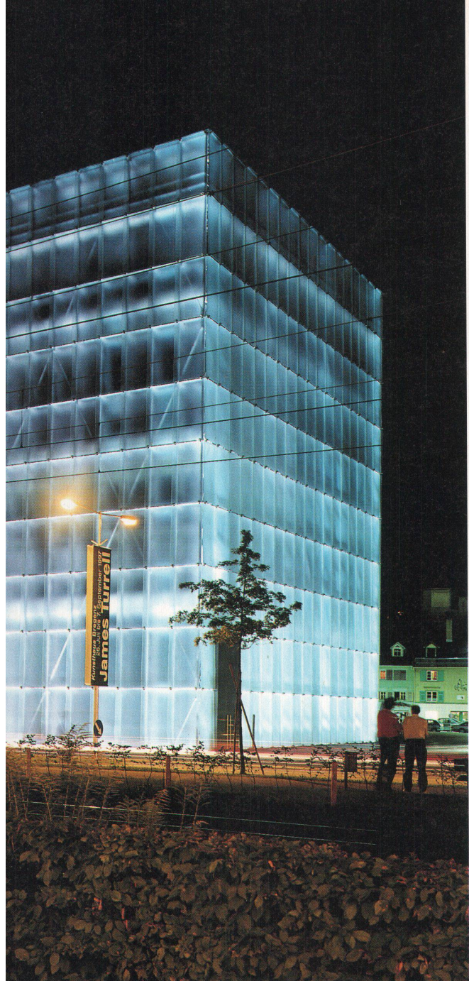
James Turrell hat für die Eröffnungsausstellung das Gebäude zur Lichtorgel gemacht
