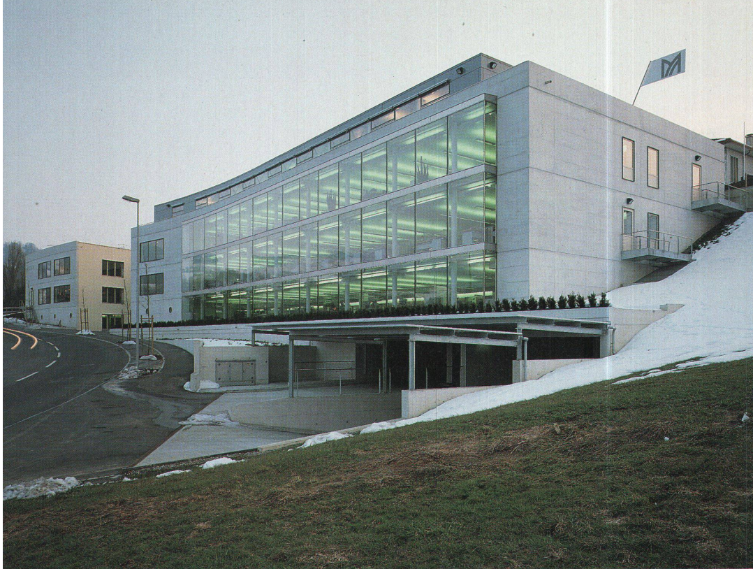
Hauptgebäude mit Glasfront, dahinter Hof und Kopfgebäude mit Bandfenstern und Bullaugen. Die Fassade ist selbsttragend, der Kern ein Skelettbau. Im Vordergrund die Einfahrt zur Tiefgarage
