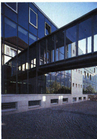
Die Fassadenelemente bestehen aus beschichtetem Isolationsglas, dazwischen Gummi. Die Fensterflügel sind aus Aluminium
