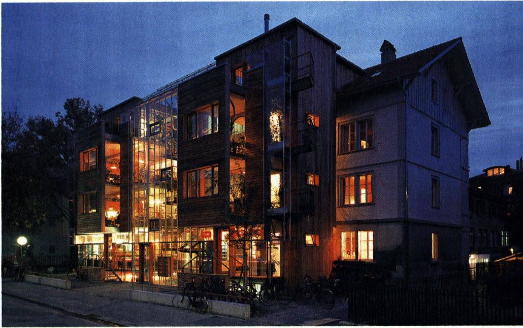
Die zwei neuen Türme auf der Strassenseite des Hauses mit Küchen, Toiletten und den «Nouvel-Balkonen». Im Erdgeschoss das Café Kairo und der Waschsalon «Jet-Wash»
