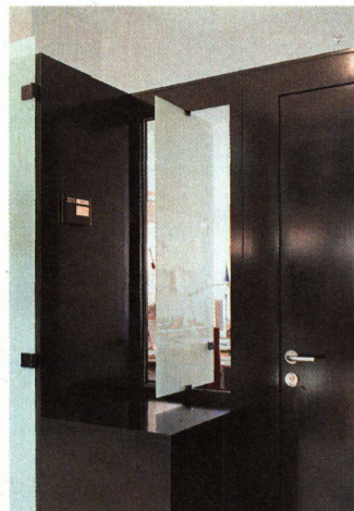
Punkt 3 + 5: Die Lüftungstürchen zwischen Gang und Büros bringen frische Luft
