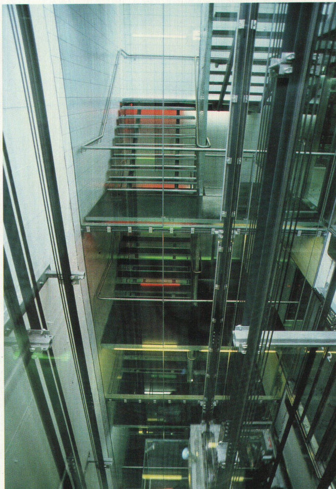
Im weissen Schacht bewegen sich drei gläserne Kabinen auf und ab, daneben die Treppe aus verzinktem Stahl
