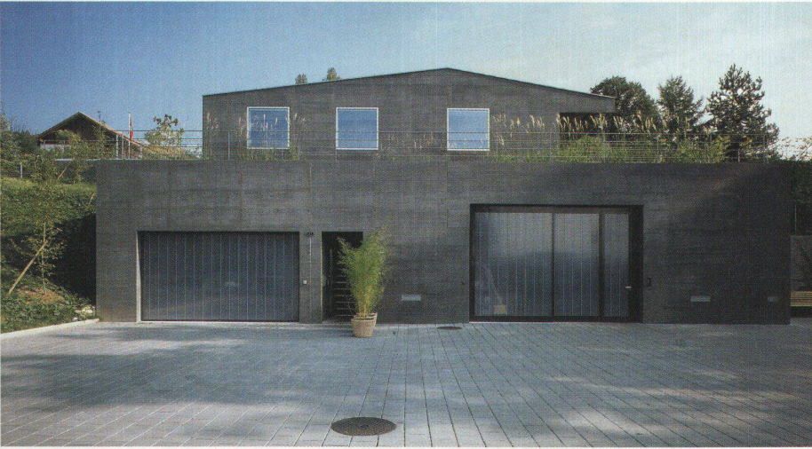
Der schwarz eingefärbte Sichtbeton und die minimalisierten Dachkanten heben das Haus von der Umgebung ab
