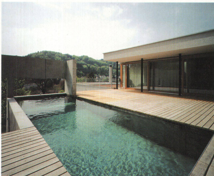
Das Schwimmbad auf der Dachterrasse
