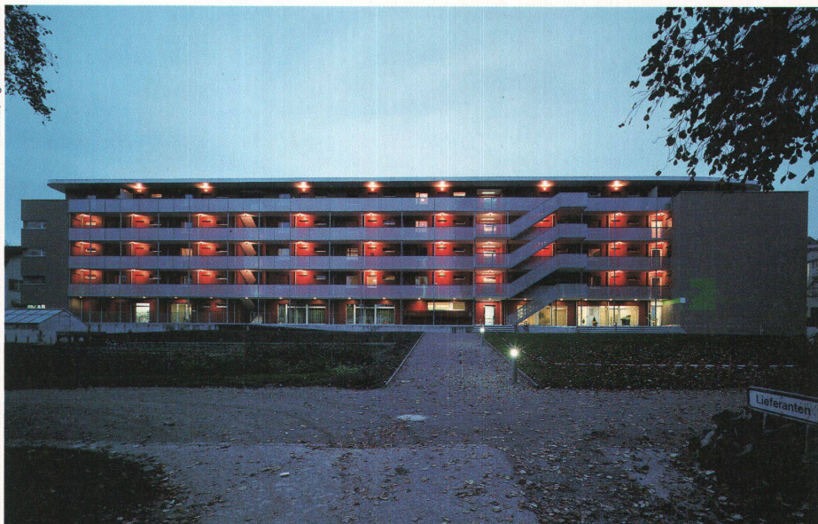
Eingangsseite mit Erschliessung über Laubengänge
