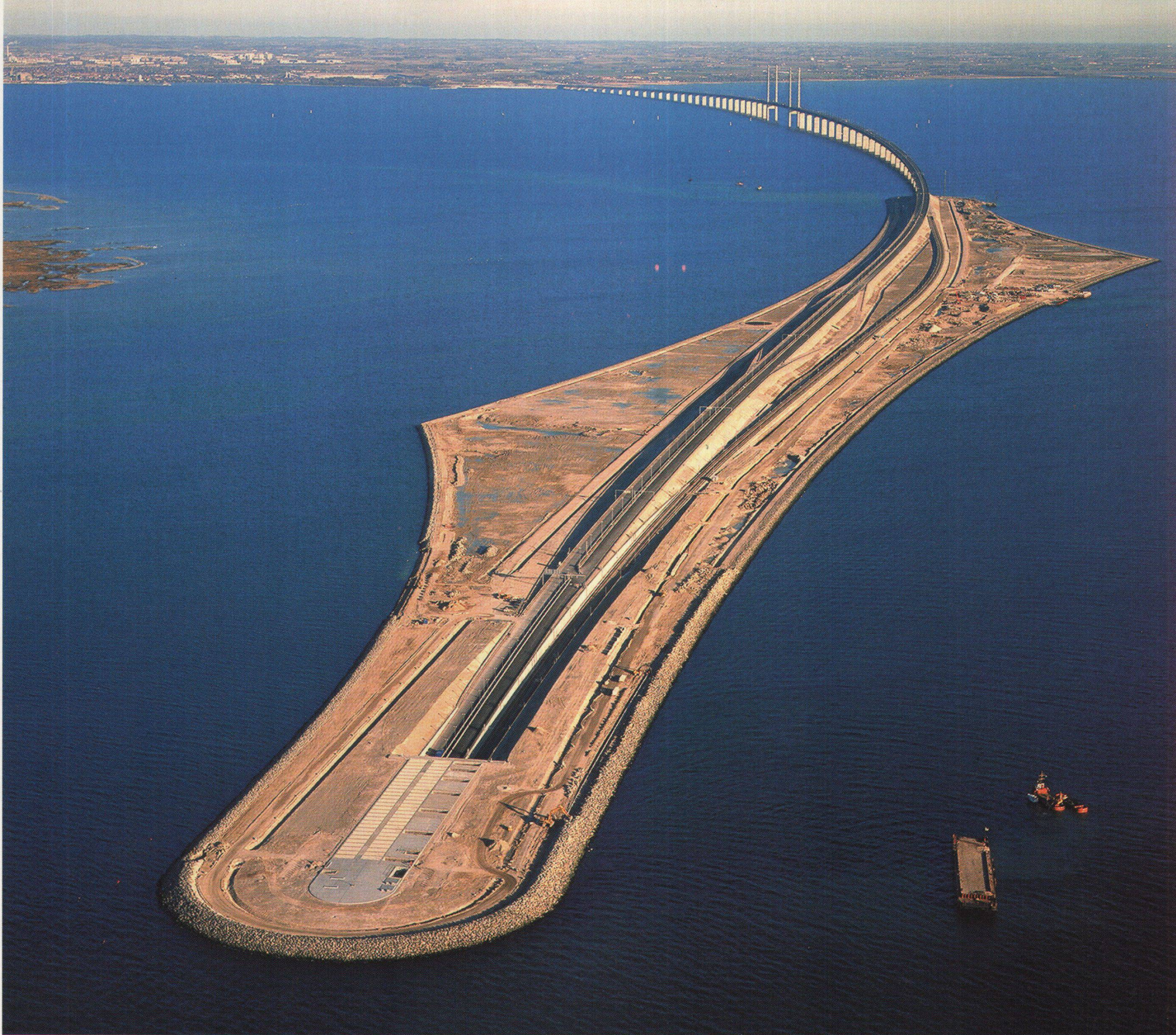
Die künstliche Insel: Eisenbahntrasse und Autobahn tauchen nebeneinander aus dem Senktunnel, die Eisenbahn schlauft in einer Kurve in die untere Etage der Brücke. Die Insel besteht aus dem Material, dass die Brückenbauer für die Brückenpfeiler aushoben – und dem Material, das sie am Meeresboden ausheben mussten, um den Wasseraustausch zwischen der Nord- und Ostsee auszugleichen, den die Brückenpfeiler behindern
