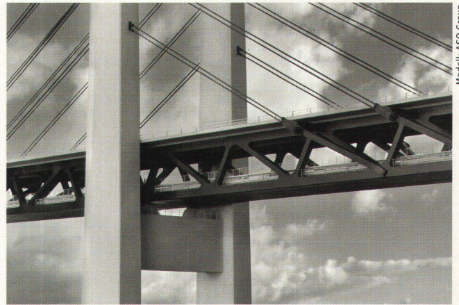
Modell der Schrägkabelbrücke: Sämtliche Kabel haben die gleiche Neigung, was bei Schrägkabelbrücken nicht üblich ist. Die gleiche Neigung soll ein besseres Bild ergeben, vor allem für jene, die daran vorbeifahren. Das Fachwerk im Bereich der Hauptbrücke übernimmt die Neigung der Kabel und der Ausleger, woran die Kabel befestigt sind
