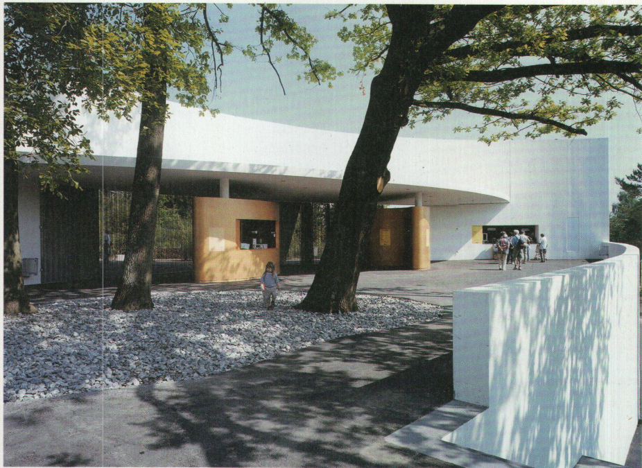
Die gebogenen Formen des neuen Eingangsgebäudes des Zürcher Zoos erinnern an die südamerikanische Kolonialarchitektur von Luis Barragàn
