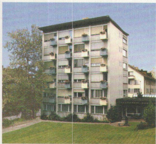
Oben: das Hochhaus des Alterszentrum Egelmoos vor dem Umbau
