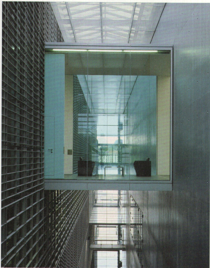
Die drei Glasbrücken zu den Ausstellungsräumen im mittleren Trakt (rechts)
