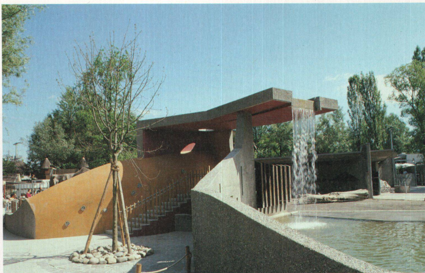
Aussichtsplateau (unter dem Wasserfall) für die Besucher und Dusche für die Elefanten. Die gelb eingefärbte Betonwand trennt Besucher und Elefanten und ist gleichzeitig Elefantenkratzwand
