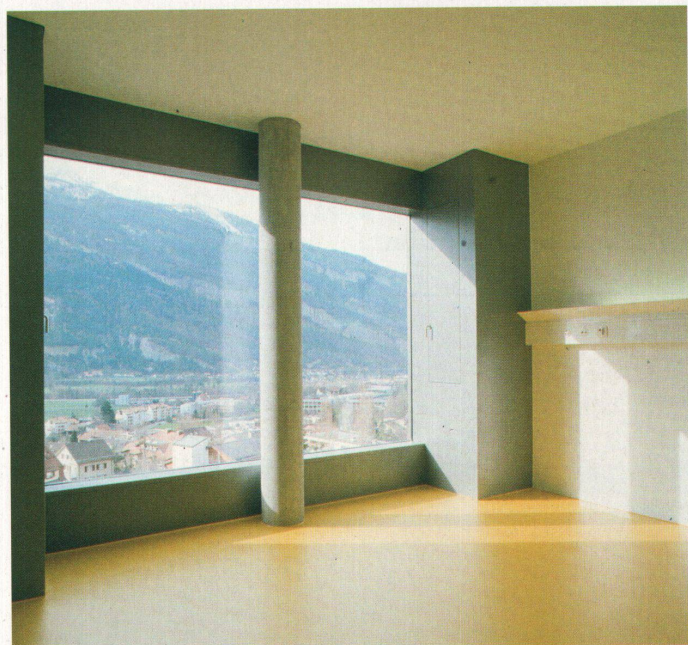
Krankenzimmer. Das Fenster ist als Erker ausgebildet, rechts im Aluminiumkasten der Lüftungsflügel
