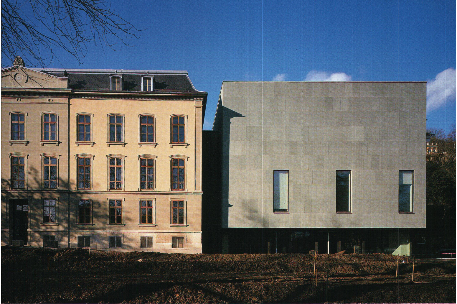
Links: Der Aufbau ist von aussen ablesbar: Verglastes Erdgeschoss unten, Seitenlicht- säle in der Mitte und Oberlichtsaal oben
