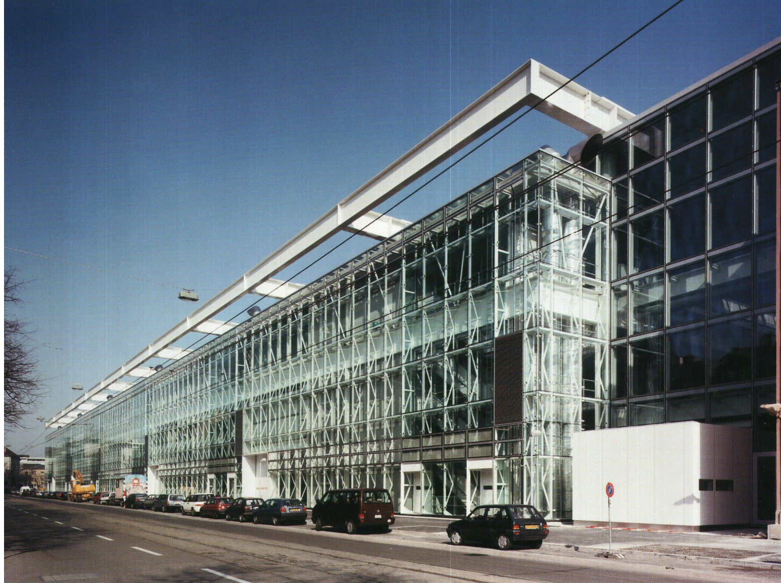
Ein stählernes Kranzgesims ohne statische Funktion krönt das 210 Meter lange Glashaus
