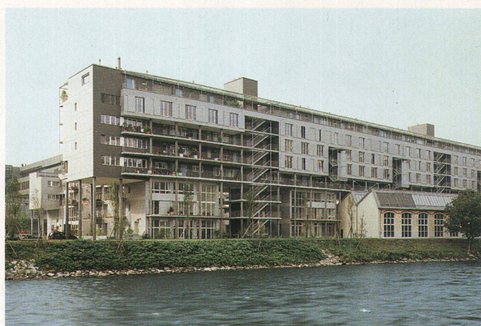
Limmatwest Flusseite. Der Wohntrakt ist auf dreigeschoss hohen Säulen aufgeständert. Rechts der Mehrzwecksaal, alles, was von der einstigen Fabrik übrig blieb
