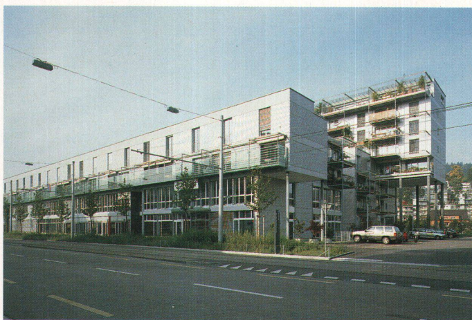
Limmatwest Strassenseite. Die zwei Geschosse Gewerbe unten und die zwei Geschosse Wohnen oben sind deutlich abzulesen. Alle Wohnungen werden von der Zwischengasse her erschlossen
