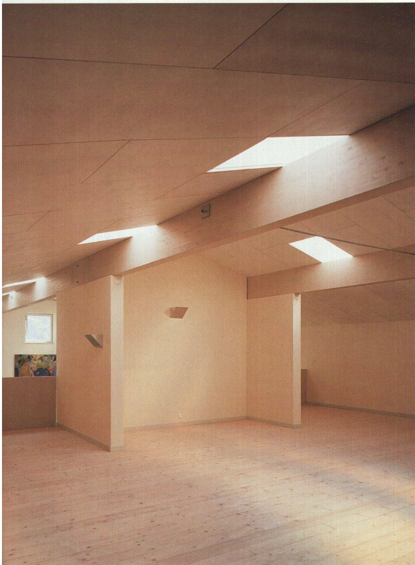
Das Sonnenlicht fällt durch die sechs Oberlichter ein und wird am Balken in den hinteren Teil des Ausstellungsraums umgelenkt. Geheizt wird dieser Raum mit Cheminéeöfen
