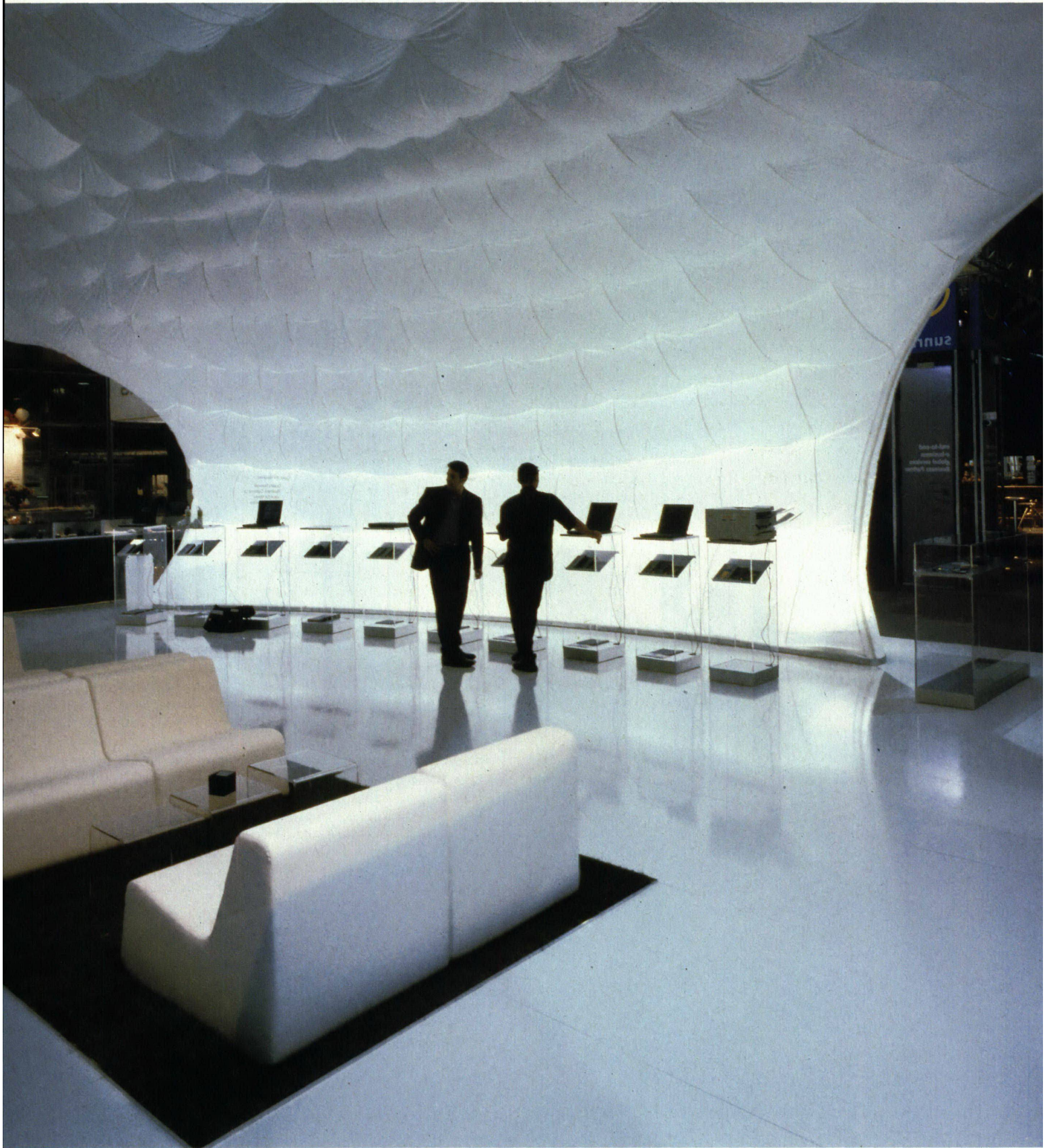
600 Quadratmeter misst die Kuppel von Stefan Zachleder. Die Eingänge sind mit Stahlrohnbögen stabilisiert
