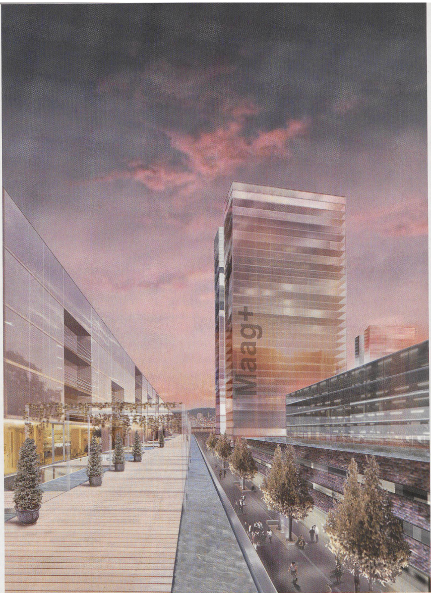
Das Terrassengeschoss bildet einen zweiten halböffentlichen Stadtboden für die Wohnungsmieter
