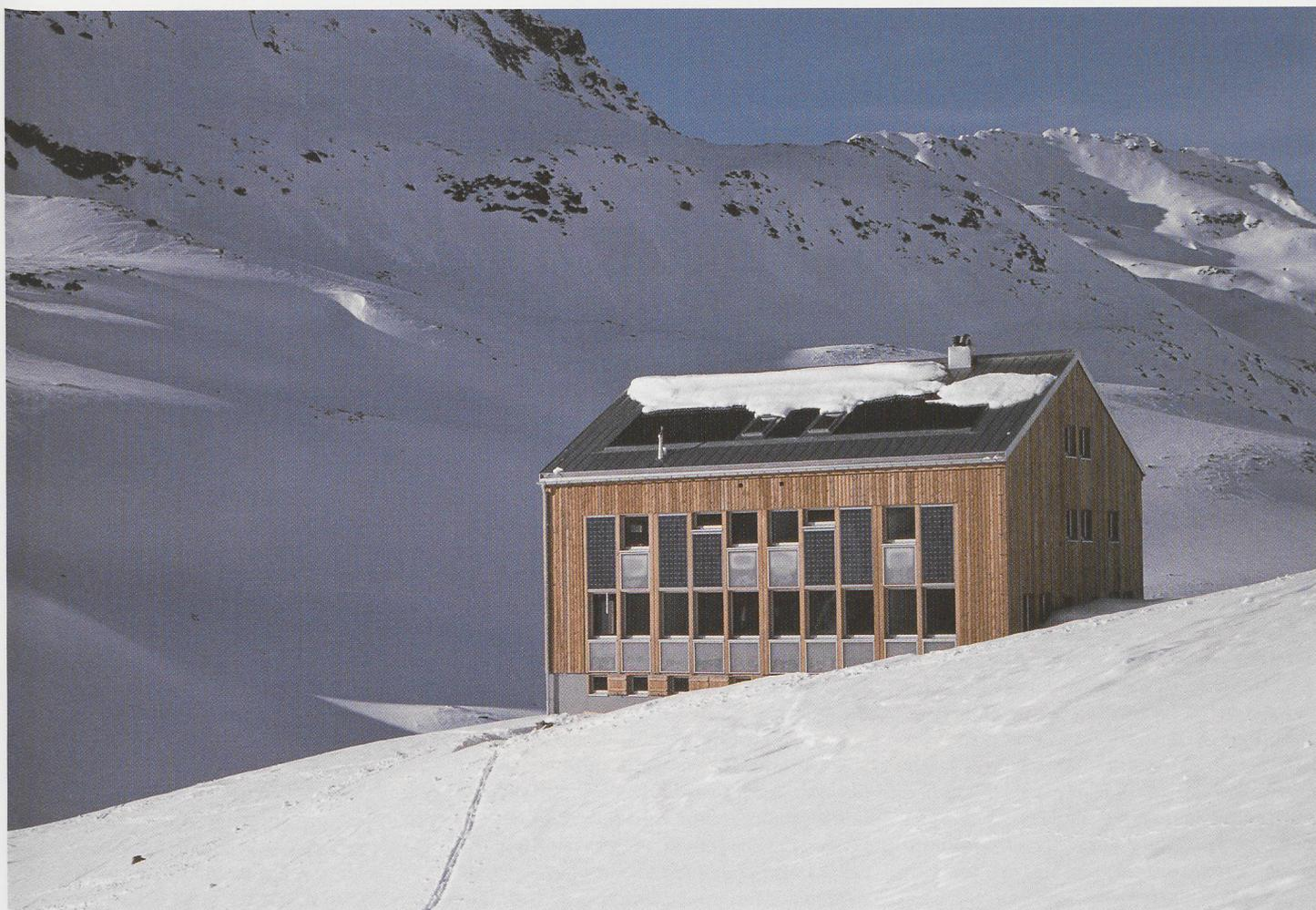
Die Keschkütte liegt in den Albula-Alpen auf 2630 Meter über Meer. Sie nutzt aktive und passive Solartechnologie für Heizung, Beleuchtung, Warmwasser und zum Kochen
