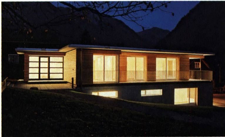
Der kompakte Bau mit offener Lärchenschalung und integrierter Wärmedämmung
