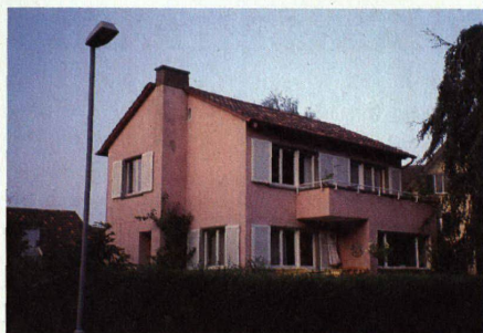
Das Haus in Zürich-Wollishofen vor dem Umbau: bodenständig und bieder. Beim Wohnzimmerfenster und beim Balkon schimmern die Dreissigerjahre durch
