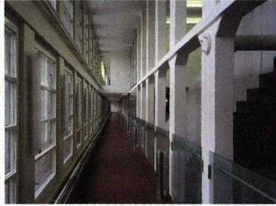
Vor dem Südportal soll später ein Bau stehen und die Passage soll in eine Halle münden. Deshalb gibt es hinter dem Sturzband aus Beton ein Oberlicht
