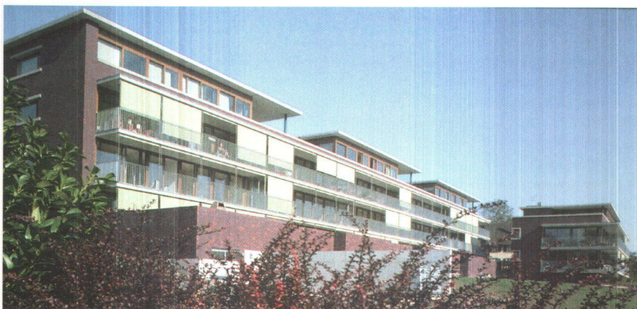
1 Die beiden Gebäude der Siedlung Neuhaus begrenzen einen Grünraum, über den man von den Balkonen in das Limmattal blickt. Im mit Klinker verkleideten Sockel liegt die Tiefgarage, darüber der Aussenraum der Erdgeschosswohnungen. Foto: René Furer
