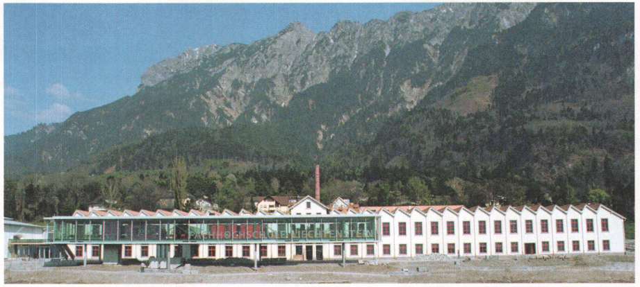
1 Der Glaskörper vor der langen Fabrikfassade signalisiert, dass eine neue Nutzung ins alte Gemäuer eingezogen ist. Fotos: Heinz Preute
