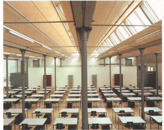
3 In den Architekturateliers blieb der Charakter der Fabrikhallen mit ihren nach Norden gerichteten Sheddächern erhalten.
