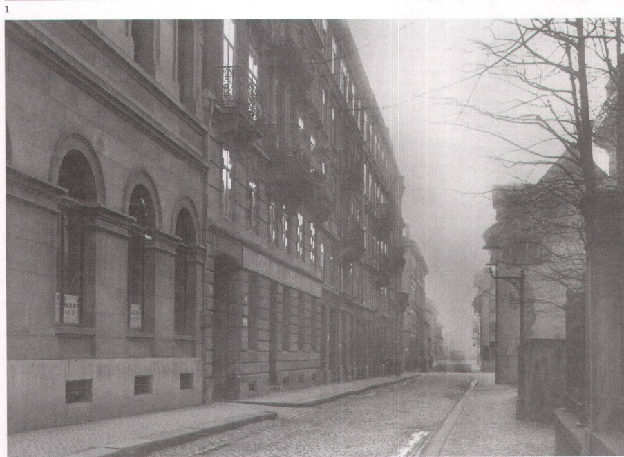
1 Postgebäude des Architekten Heinrich Honegger von 1872/73. Die Säulen stehen in Kolossalordnung über dem rustikalen Sockelgeschoss. Die Gesimshöhen der beiden Nachbargebäude hat Wanner weitergeführt. Aufnahme um 1880. Foto: BAZ
