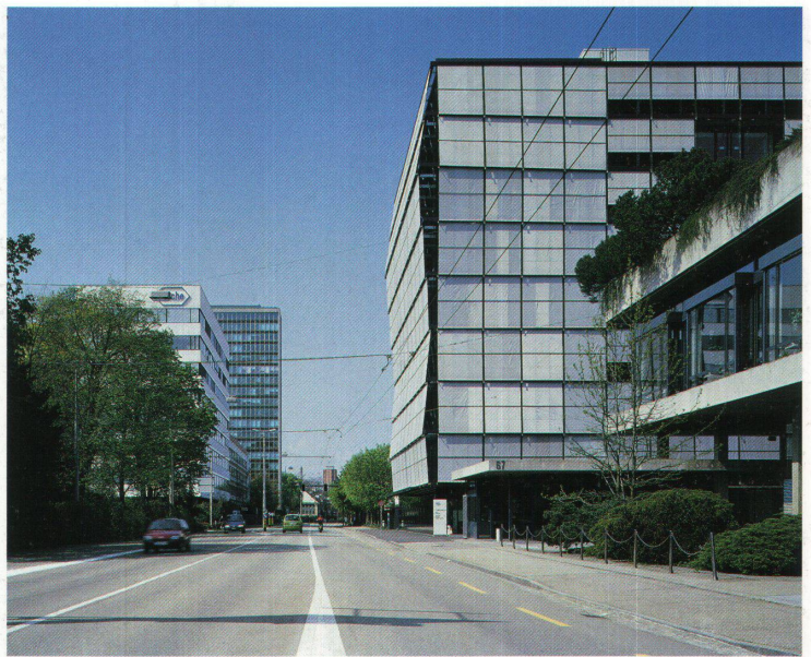
Das Gebäude steht direkt an der Trottoirkante und tritt in der Grenzacherstrasse markant in Erscheinung. Die Sonnenstoren binden das zweigeschossige Foyer und im grossen Bogen die Bibliotheksgeschosse zusammen
