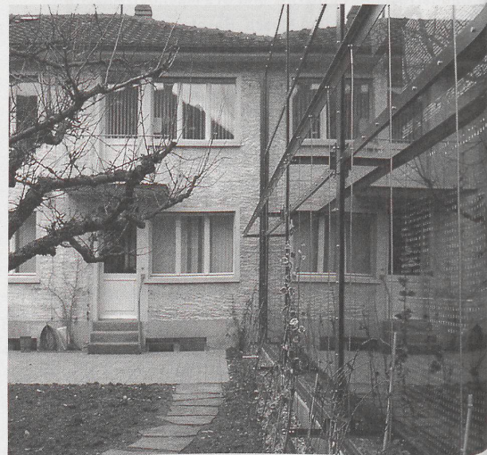
5 Transparenz hat der Architekt nicht einfach mit «Glas» übersetzt: Lochblech verhindert im unteren Bereich der Wände weitgehend den Einblick in die Gärten, im oberen Bereich wirkt es eher als Vorhang.
