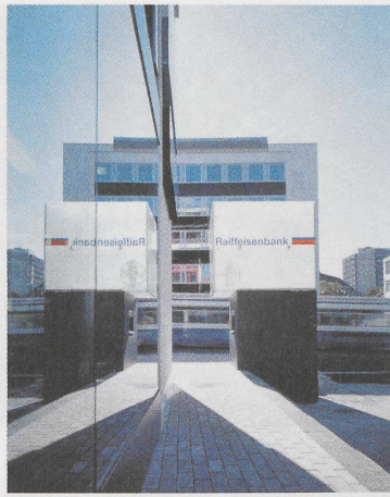
1 Ein Lichtwürfel über dem Aussen-Bancomaten markiert die Raiffeisenbank an der Gabelung Schwamendinger-/Schaffhausstrasse. Foto: Francesca Giovanelli
