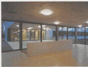
1 Die Betondecke und der Boden aus Hartbeton führen aus dem Innern des Foyers nach aussen und verbinden die Mehrzweckhalle mit dem Schulhaus. Fotos: Heinrich Helfenstein
