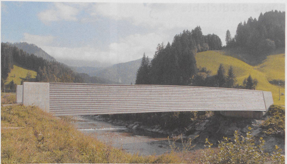
1 In flachem Bogen überwölbt die Schartenmattbrücke die Ilfis. Eine Holzschalung schützt die Träger vor der Witterung.
