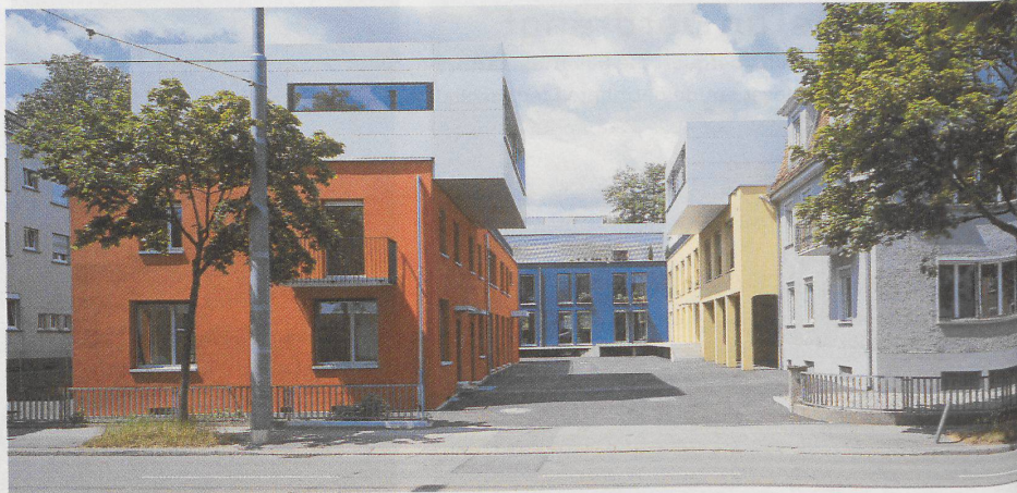
1 So kann man Ausnutzungsziffern ausnutzen: Der Umbau der Farbenfabrik Boller-Benz zu Wohnungen mit Holzrucksäcklein, verkleidet in Alu. Fotos: Andrea Helbling
