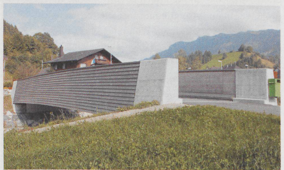
1 In flachem Bogen überwölbt die Schartenmattbrücke die Ilfis. Eine Holzschalung schützt die Träger vor der Witterung.
