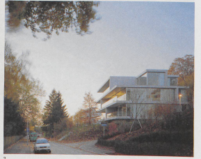
1 Die leicht glänzenden Betonscheiben transportieren das Grün der Umgebung in die Tiefe der Räume.
