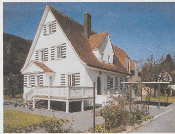
1 Das steile Dach ist typisch für die Bauten der Architekten Dehm & Nigg in Bad Ragaz.
