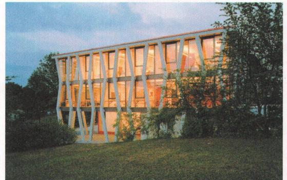
**1 Ein Vorhang aus geknickten Betonstützen hüllt die Glaskiste auf drei Seiten ein. Darunter liegt der im Bauprogramm geforderte Anteil an gedecktem Pausenplatz.**
