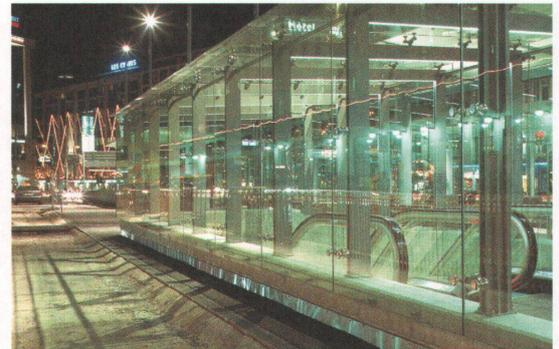
1 **Wo das Wettbewerbsprojekt ein grosses Dach auf 14 Metern Höhe vorsah, hängen jetzt zwei schmale Glasdächer an einem überdimensionierten Stahlgestell.**
