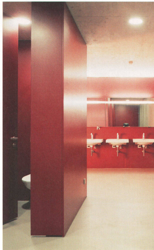
2 Bétrix & Consolascio setzten ihre Architektur auch in den Toiletten durch: Sockellose Wände brauchen sensiblere Reinigung.
