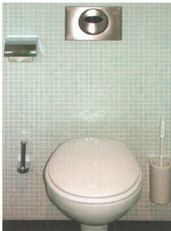
1 1 Dank Sensortechnik auch im halböffentlichen Bereich des Ramada-Restaurants immer saubere Toiletten.
