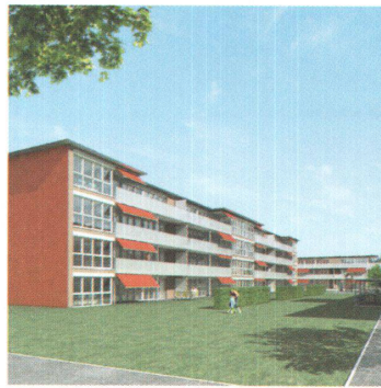
Die Wohnüberbauung Hohfuren (16, Seite 8)
