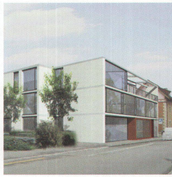
Überbauung Freiestrasse (44, Seite 8)
