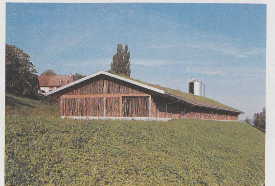
3 Durch Weiterziehen der Wiesenflächen auf die Dachflächen wird das Volumen in die Umgebung integriert, die zwei glänzenden Futtersilos sitzen innerhalb des Kuhstalls, durchstossen jedoch an einer Stelle das Gründach. Foto: Christian Baur
