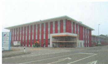
Neubau Schreinerei Heim, 2006 Juch, Waltenschwil --> Bauherrschaft: Heim AG, Walten- schwil --> Projekt und Ausführung: Holzbau Erni AG, Schongau --> Fassade: Holzbau Koch AG, Büttikon
