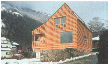
Einfamilienhaus Stiege, 2003 Bürglen
