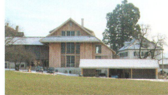
Ersatzbau Scheune, 2005 Rifferswil
