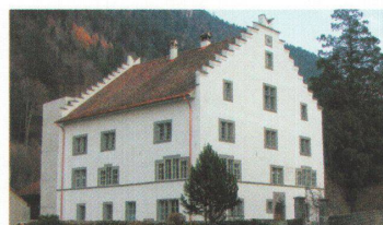
Restaurierung Suworowhaus, 2006 Altdorf --> Bauherrschaft: Stiftung Karl Jauch, Altdorf --> Architektur: Werner Furger, Altdorf --> Holzbau: Bissig, Altdorf; Schuler, Bürglen; Furger, Bristen
