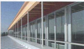
Produktions- und Bürogebäude, 2003 Zellfeld, Schenkon --> Bauherrschaft: Vici AG, Schenkon --> Architektur: W. R. Leuenberger, Sursee --> Holzbau: Trüssel Holzbau, Schenkon; Tschopp Holzbau, Hochdorf
