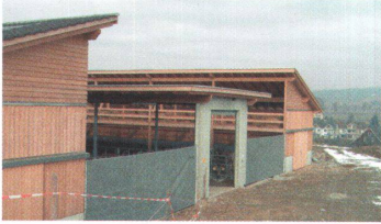
Mutterkuhstall, 2005 Baldegg --> Bauherrschaft: Institut Baldegg, Baldegg --> Architektur: planteams.ch, Sarnen --> Holzbau: Tschopp Holzbau, Hochdorf
