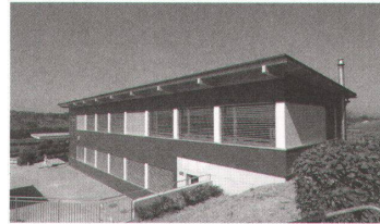
Neubau Schulhaus, 2005 Gisikon --> Bauherrschaft: Einwohnergemeinde Gisikon --> Architektur und Holzbau: Schaer- Holzbau AG, Altbüron
