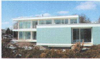
Einfamilienhaus, 2006 Zugersee --> Architektur: Alfred & Thomas Krähen- bühl, Zug --> Holzbau: Xaver Keiser, Zug --> Ingenieur: Walter Beeler, Bonaduz --> Landschaft: Erich Andermatt, Zug
