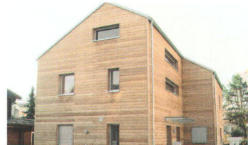
Umbau Wohnhaus, 2005 Hertistrasse, Brunnen
