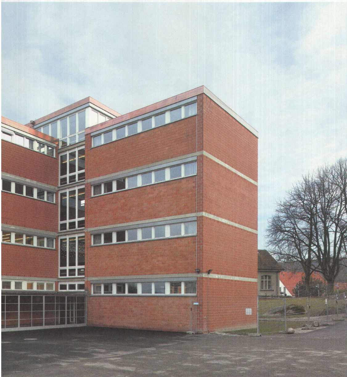
Die neu aufgemauerten Westfassaden (nach rechts blickend) sind homogener und etwas dunkler als die Originalfassaden.
