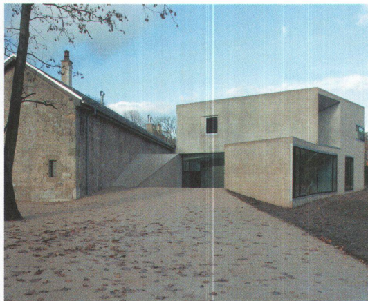
1 Der Neubau hat zwar einen kräftigen Auftritt, doch spielt der Altbau noch immer die Hauptrolle. Fotos: Francesca Giovannelli
