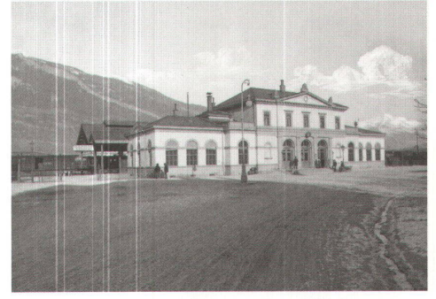
1878 Neubau des Aufnahmegebäudes
