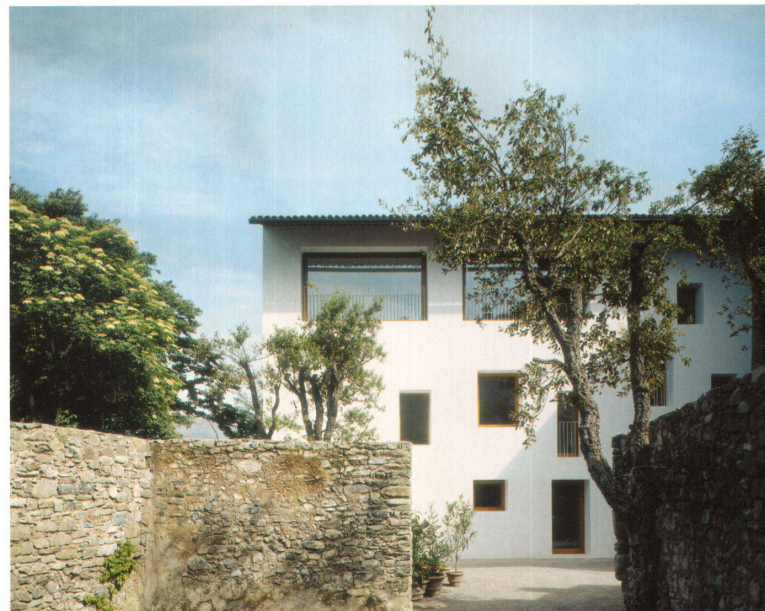
^ Auf das weisse Papier der Fassade notierte der Architekt scheinbar zufällig die Fenster.
