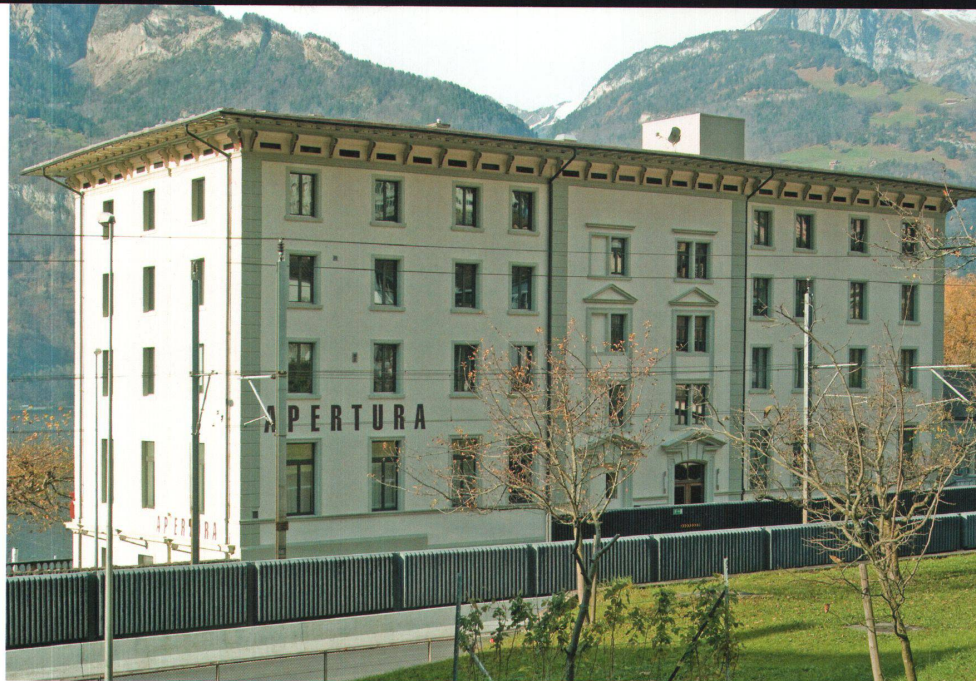
^ Hinter der Bahnlinie, vor den Bergen: Einst das Hotel Urnerhof in Flüelen, heute Wohn- und Gewerbehau. Foto: Karin Herger
