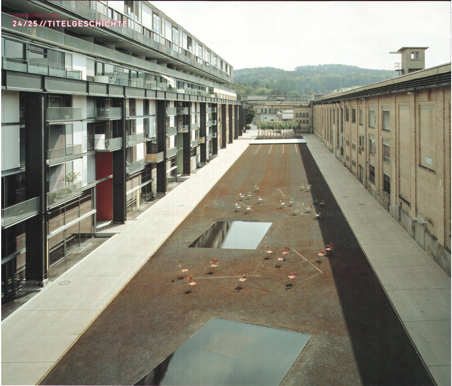
^ Katharina-Sulzer-Platz: in Beton gefasste Weite. Fotos: Ralph Feiner
